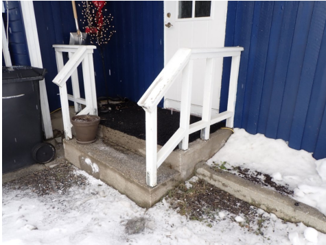
Trapp ved inngang
