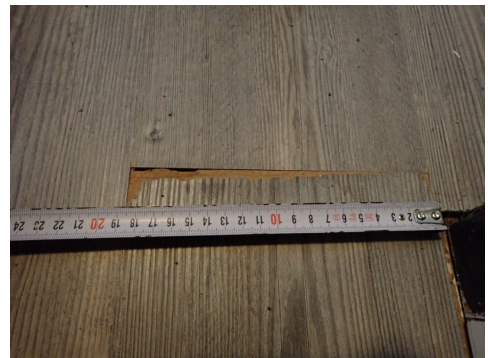
Eksempel på skade i laminat, hall
