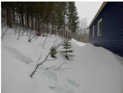
Terrengtet skråner inn mot boligen
