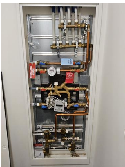
Tekniske anlegg, VVS anlegg (Sjekkpunkter utover det som er inkludert i andre rom) - [Fordelerskap.]
