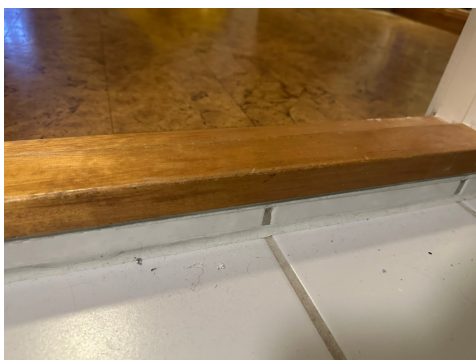
Overgang mot dørterskel.
