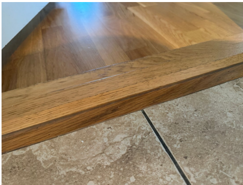
Overgang mot dørterskel.
