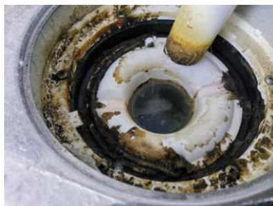
Membran, tettesjikt og overgang til sluk. - [Sluk under dusjkabinett, bad 1. etg.]
