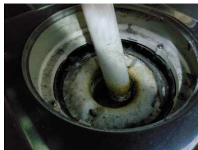
Membran, tettesjikt og overgang til sluk. - [Sluk under badekar, bad 1. etg.]
