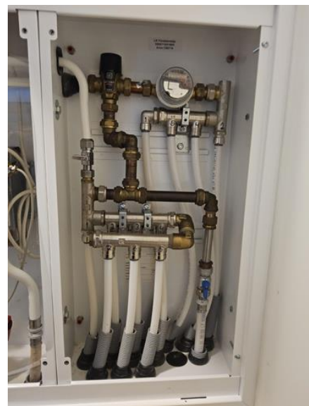
Vannrør (Sjekkpunkter utover det som er inkludert i andre rom) - [Fordelerskap for rør-i-rør-systemet]
