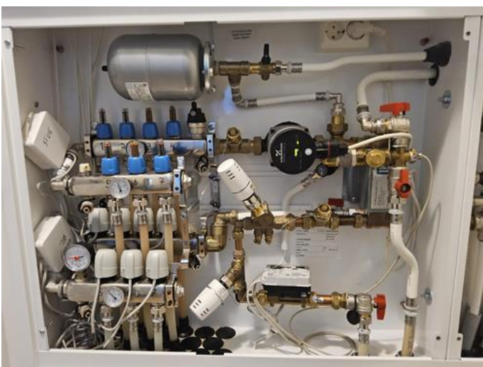
Vannrør (Sjekkpunkter utover det som er inkludert i andre rom) - [Varmefordelingsskap]
