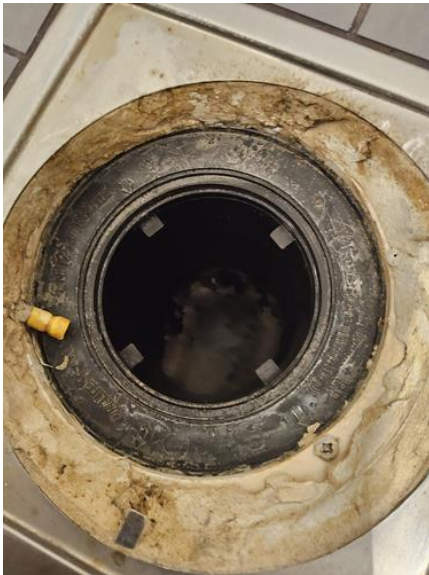
Membran, tettesjikt og overgang til sluk. - [Sluk]
