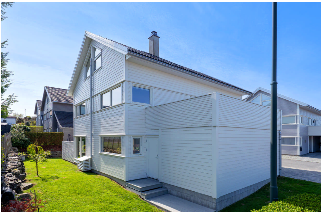
Hagen strekker seg rundt på andre siden av huset - Det er dør gjennom carporten
