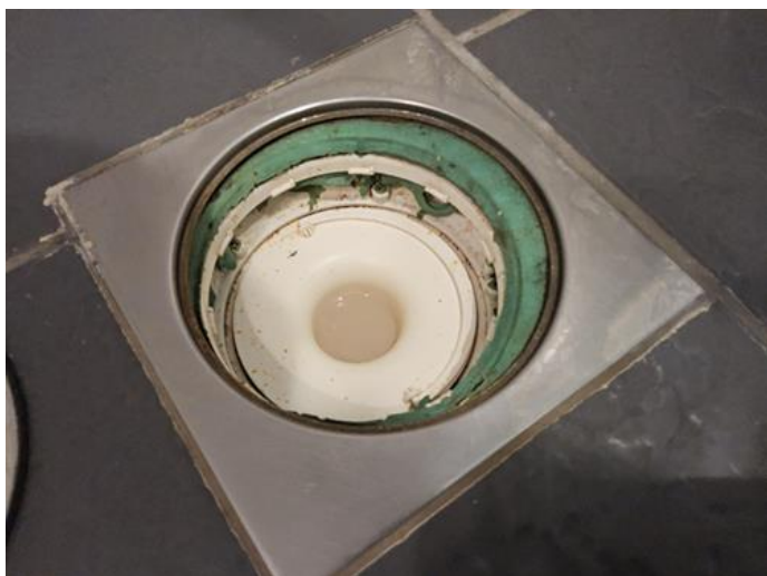
Våtrom - [Sluk på bad 2.etg (dusjsonen).]
