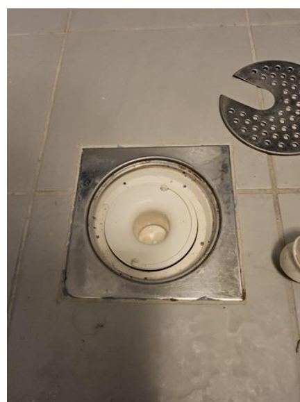
Våtrom - [Sluk på vaskerom.]
