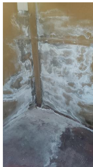
Konstruksjoner (tilfarergulv, himling og vegger). - [Fuktmerker i bod]
