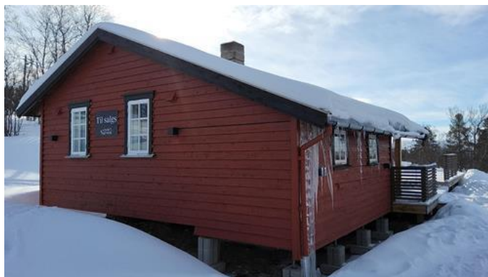
Helhetsvurdering - [Is på tak og raftkasse]
