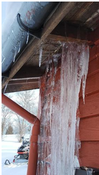
Helhetsvurdering - [Istapper i raftkasse]
