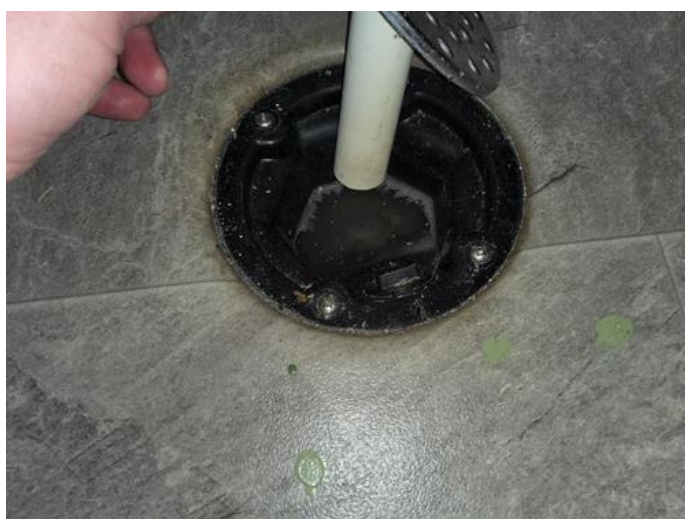
Avløpsrør (ink. sluk) - [Sluk på vaskerom. ]
