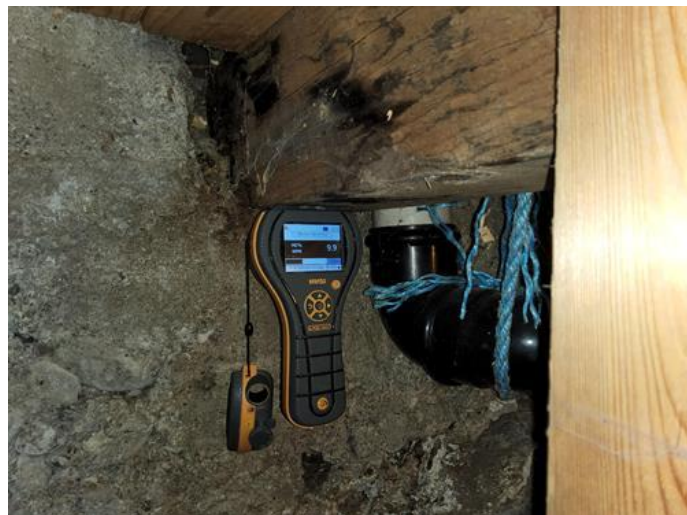
Annet - [Fuktmåling i innstøpt bjelke i kjeller.]
