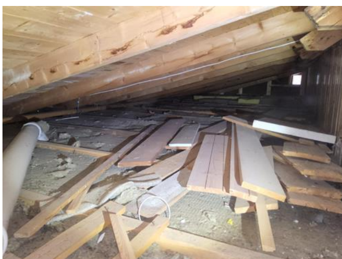
Loft - uinnredet / råloft - [Loft over tilbygg. ]
