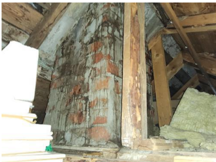
Skorsteiner inne i boligen - [Skorstein på loft. ]
