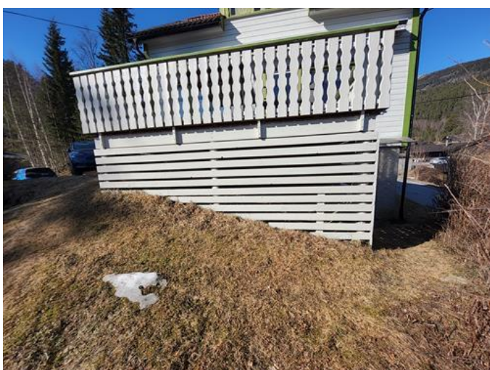
Balkonger, terrasser, veranda etc - [Spilekledning under balkong.]
