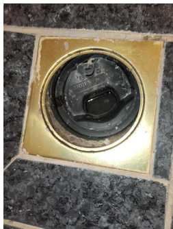
Tettesjiktets tilslutning til sluk - Sluk bad
