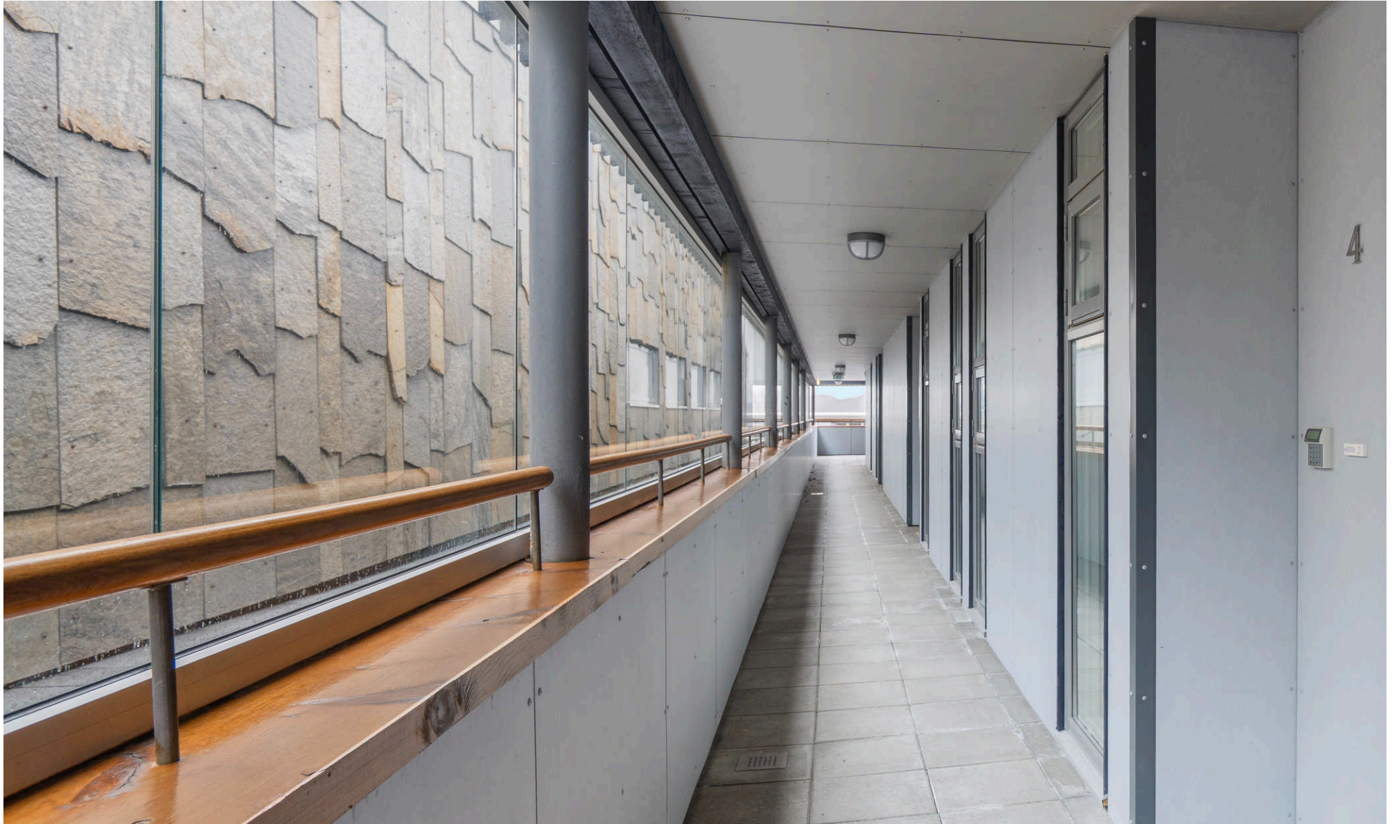
Svalgang mellom leilighetene. Den er glasset inn så man slipper unna vær og vind
