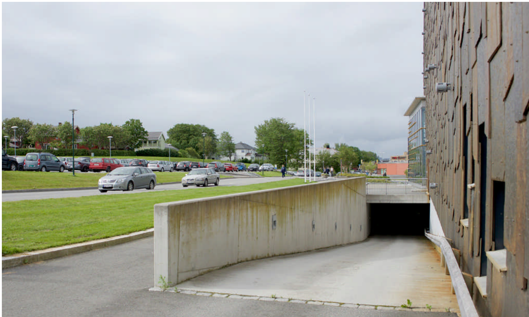
Nedgang til parkeringskjeller.
