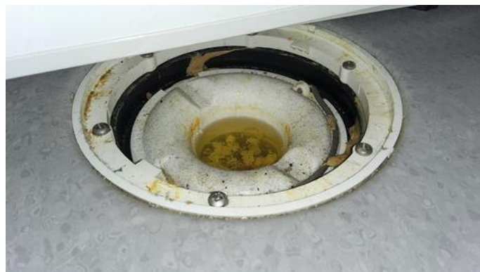
Overflater gulv - [Sluk bod]
