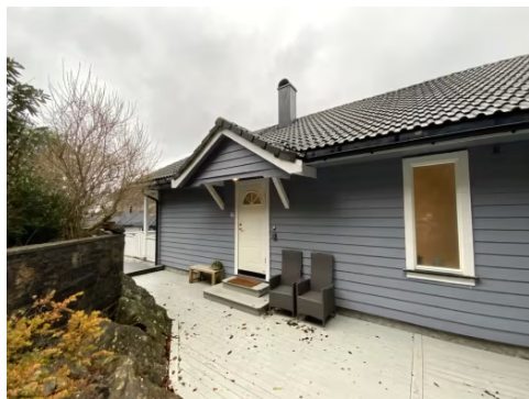
Pipe med beslag over tak
