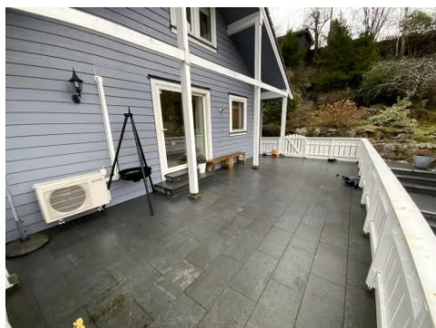
Terrasse over garasje med fliseheller
