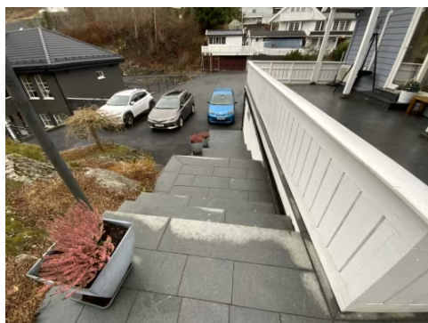
Utvendig trapp fra topp
