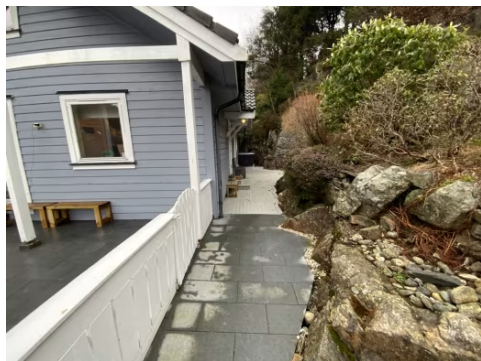
Nedløp ved terrasse
