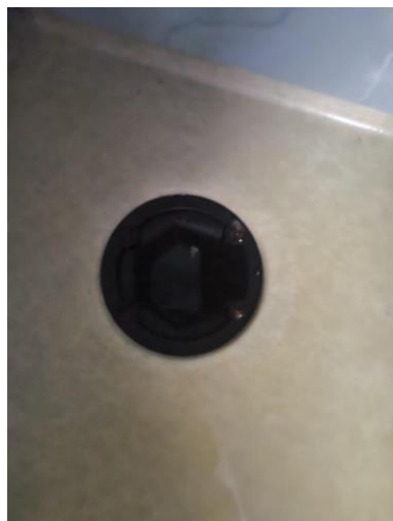
Slukets tilkomstmulighet for rengjøring - [Sluket på bad 1 etasje ]
