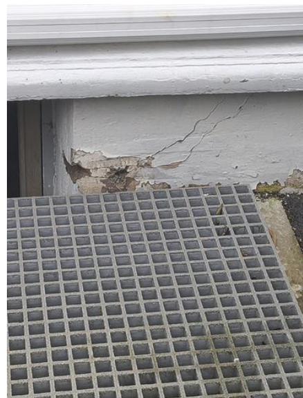
Grunnmur, fundamenter - [Grunnmur ved inngang]
