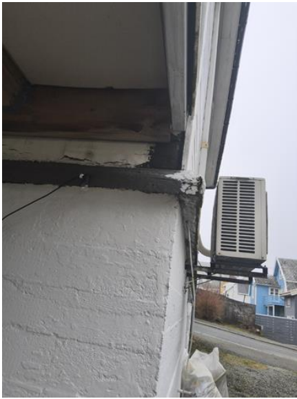
Konstruksjon - [Ytterkledning ned mot grunnmur ]
