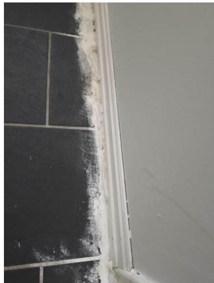
Overflater gulv - [Gulvflater i gang kjeller ]
