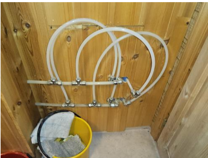
Tekniske anlegg, VVS anlegg (Sjekkpunkter utover det som er inkludert i andre rom) - [Rør i rør system]
