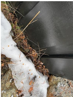
Helhetsvurdering - Kledning avsluttet nær bakke
