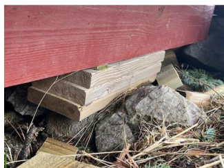
Søyler og pilarer - Eksempel på provisorisk understøttelse
