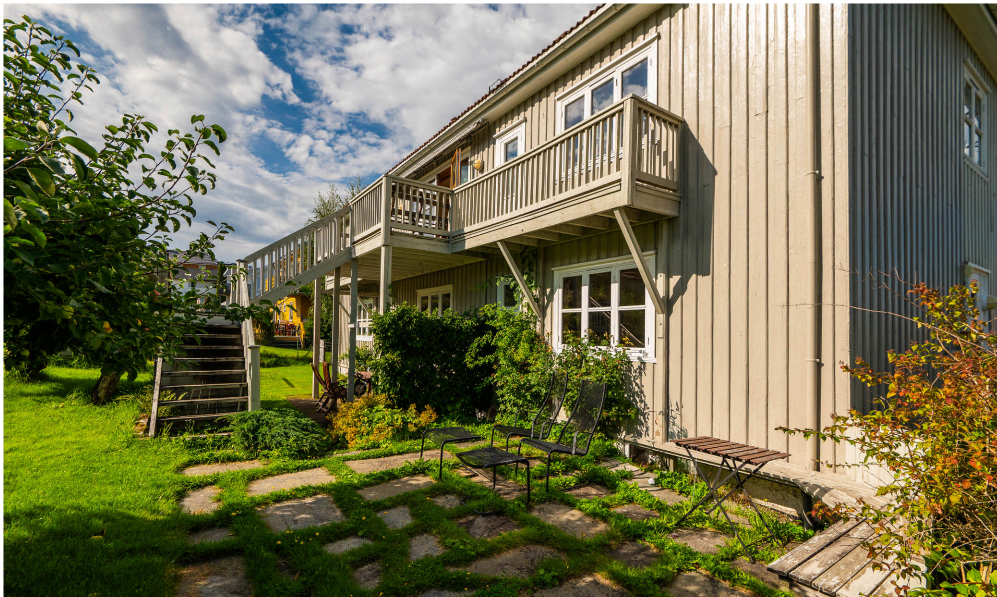
Hellelagt uteplass på bakkeplan. Trappen ned fra 2 etasje gir enkel tilgang til hagen. På gavlveggen er det egen inngang til leilighet i 1 etasje.
