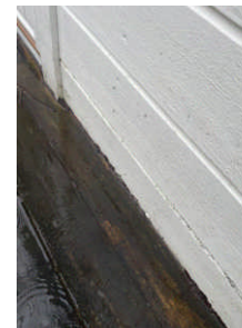
Det er tett mellom terrassebord og bordkledning/vegg.
