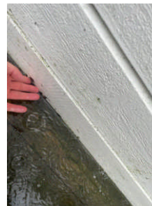
Det er tett mellom terrassebord og bordkledning/vegg.
