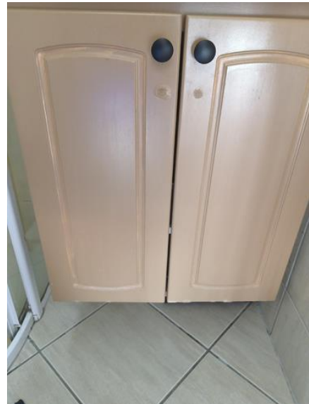
Sanitærutstyr / innredning - [Innredningen på bad ]
