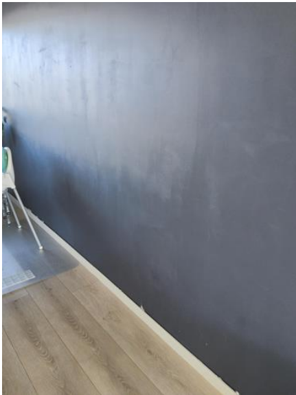
Overflater vegger - [Veggoverflater på kjøkken]
