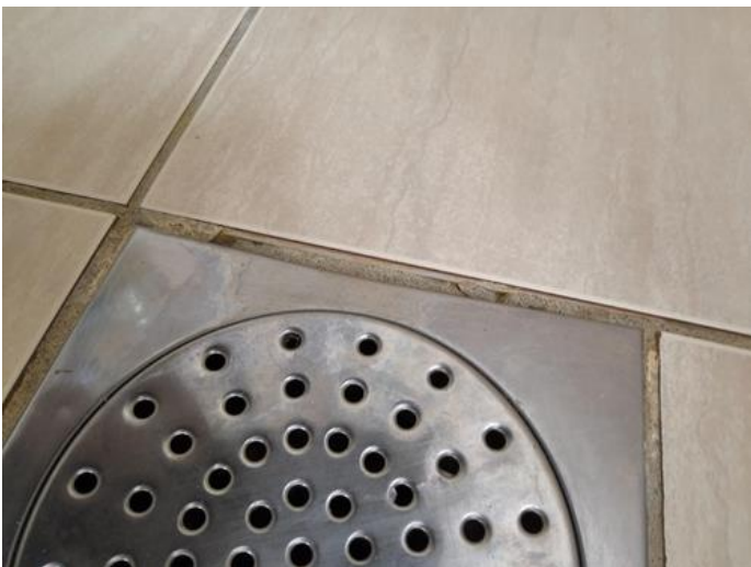
Overflater gulv - [Gulvoverflater i dusjsonen ]
