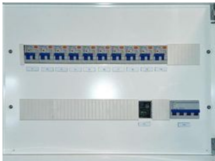
Forenklet vurdering av det elektriske anlegget - [Sikringsskap]
