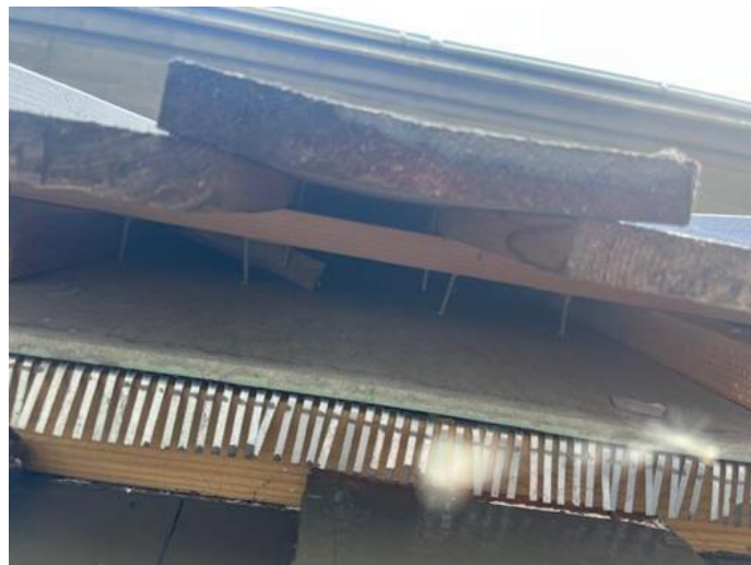
Helhetsvurdering - [Eksempel på åpninger i vegg]
