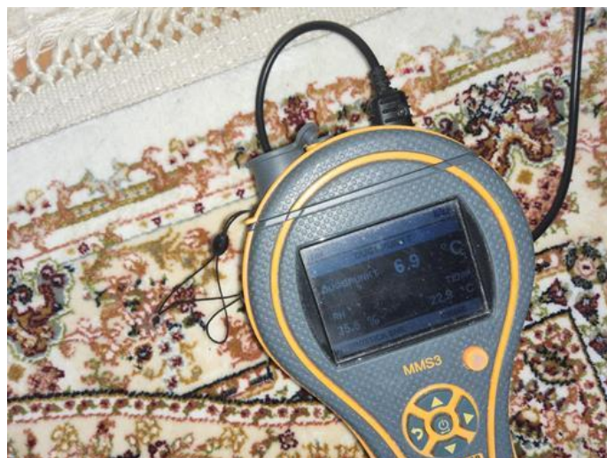
Fukt i tilliggende konstruksjoner - [Fuktmåling bad.]
