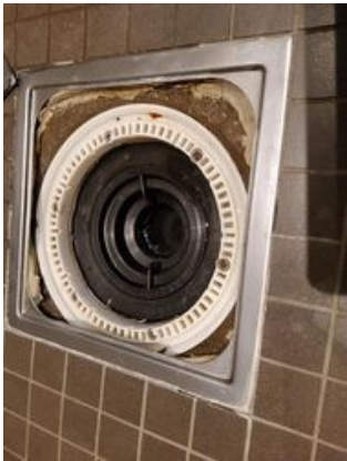
Membran, tettesjikt og overgang til sluk. - [Sluk i bad 2.]
