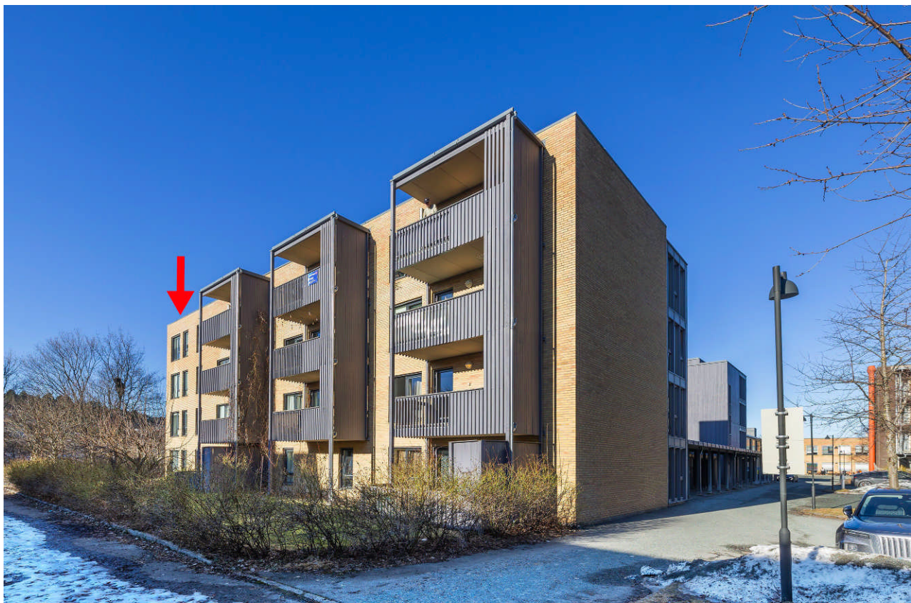
Fasade. Leilighetens plassering markert med rød pil
