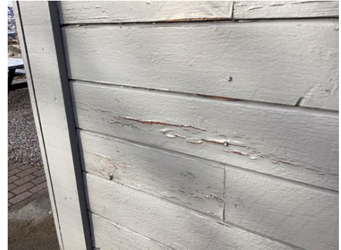
Eksempel på værslitt/oppsprukket trepanel
