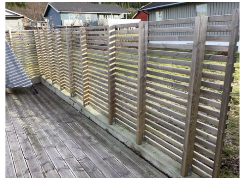
Gjerde/ rekkverk ved markterrasse
