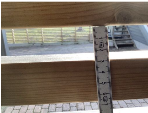
Eksempel på for store åpninger i rekkverk
