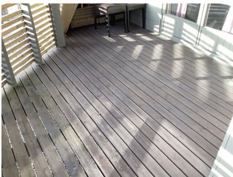
Eksempel på for store åpninger i rekkverk
