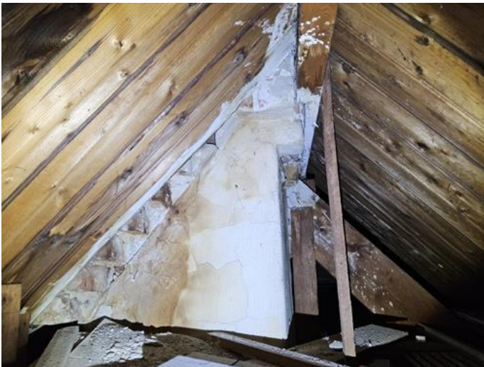
Loft - uinnredet / råloft - [Uinnredet kaldtloft.]
