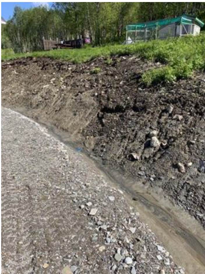
Figur 8 Avskjæringsgrøft med drensledning i bakkant av hus mot skråning.
