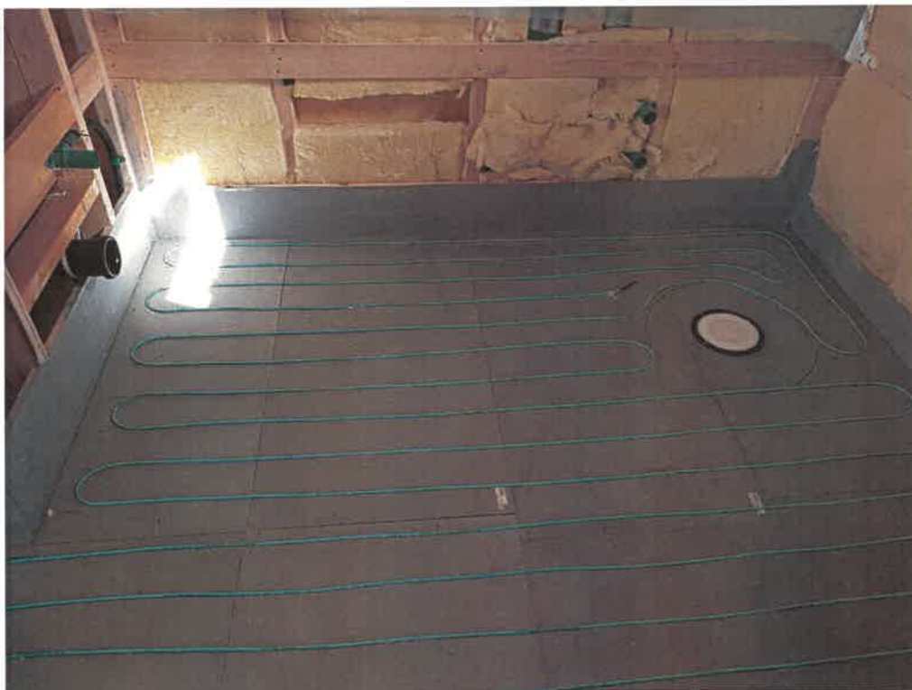
Skjema: "Varme Øglænd Systems: Bad 2 etg 6.1 m" Spørsmål: Eier/Beboer/Tiltakshaver er informert om varmesystemet Beskrivelse: Bad 2etg, Filnavn: TempImage.jpg
