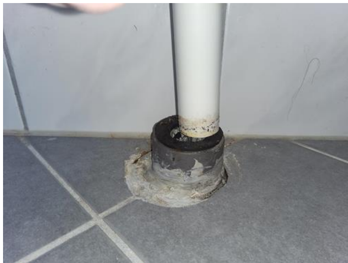
Kommentar - [Avløpsrør fra servant ]
