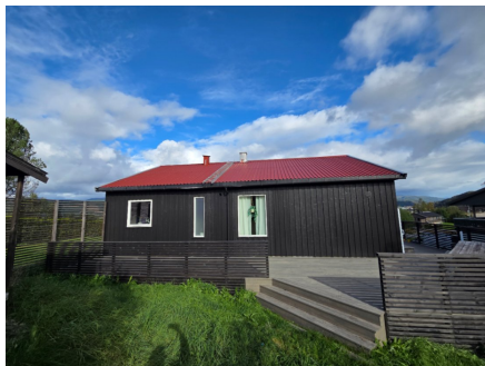
Plassbygd trapp fra veranda til terreng
