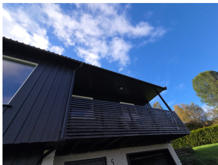
Balkong fra byggeår som er oppgradert med nytt rekkverk
