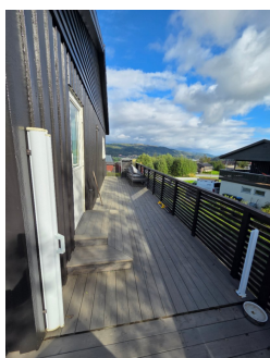
Veranda er satt opp over terreng uten faste fundamenter
