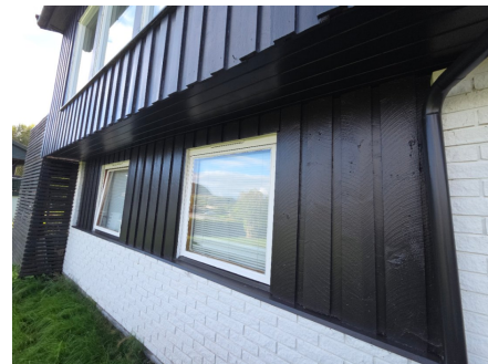
Oversikt, ingen synlig ventilering
