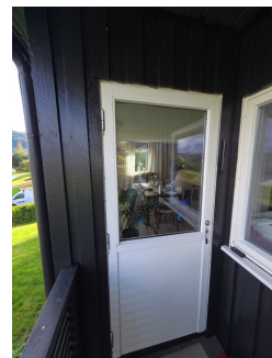
Balkongdør med utgang fra stue
