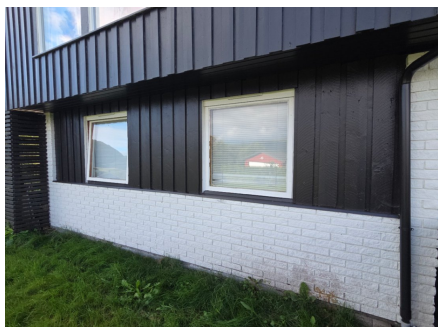
Koblede vinduer i underetasjen
