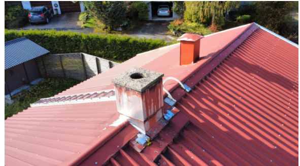
Oversikt pipe, fastmontert takstige og luftehatt
