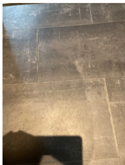
Skade/sprekk i vinylklakk som er montert i vindfang
