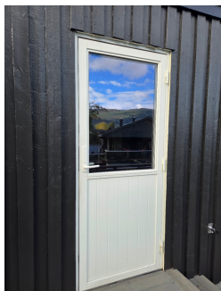
Verandadør med utgang fra stue
