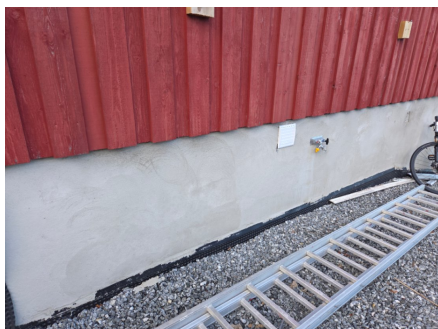
Etterisolert, ny grunnmursplast, drenering og ny puss i 2021 på vegg mot øst
