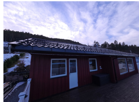
Vindu på soverom
