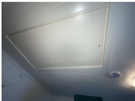
Loftsluke på soverom
