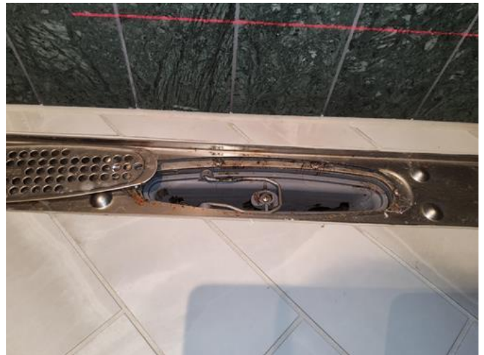
Membran, tettesjikt og overgang til sluk. - [Sluk bad kjelleretasje. ]
