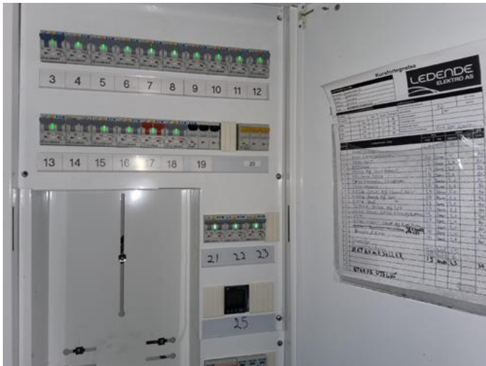
Beskrivelse - [Sikringsskap med kursfortegnelse. ]
