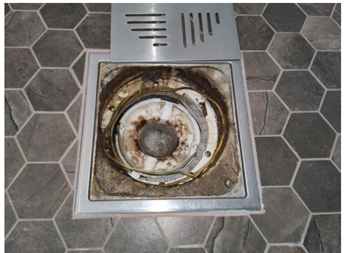
Membran, tettesjikt og overgang til sluk. - [Sluk bad 2. etasje. ]
