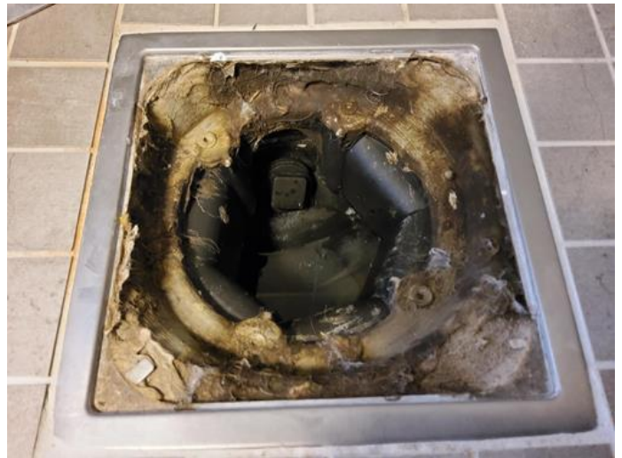
Membran, tettesjikt og overgang til sluk. - [Sluk i bad/vaskerom hoveddel. ]
