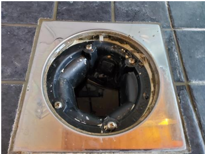
Membran, tettesjikt og overgang til sluk. - [Sluk i bad hybeldel. ]
