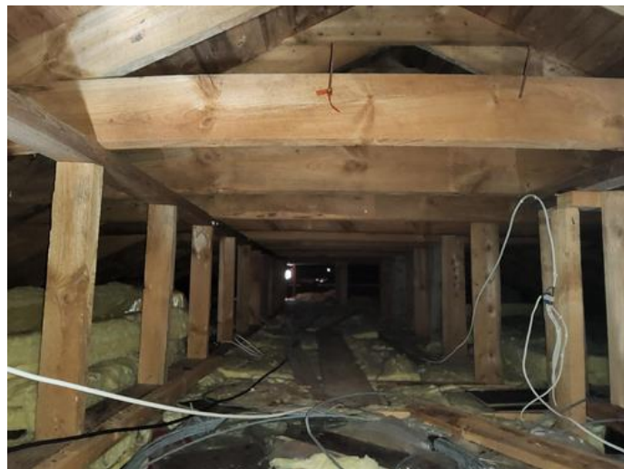
Loft - uinnredet / råloft - [Loft hovedhytte. ]
