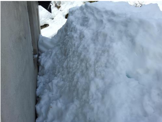
Yttervegger inkl. fasader og konstruksjon - [Eksempel på snødekkede fasader ved anneks.]
