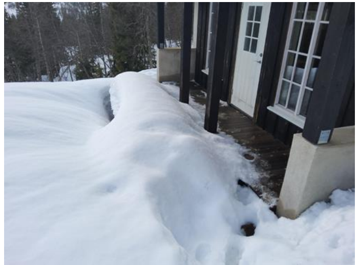
Balkonger, terrasser, veranda etc - [Terrasse ved anneks på befaringstidspunkt.]
