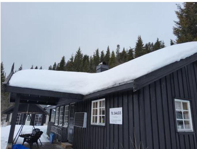
Yttertak - [Eksempel på snødekket tak på hovedhytte på befaringstidspunkt.]
