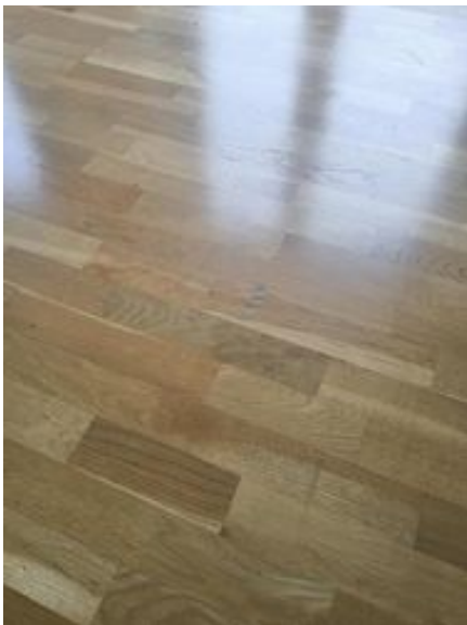
Overflater gulv - [Gulvoverflater stue ]
