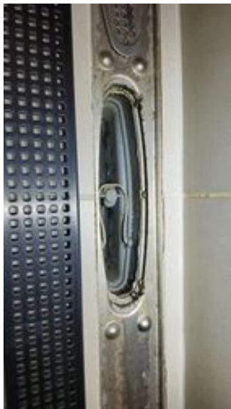
Våtrom - [Sluk bad]
