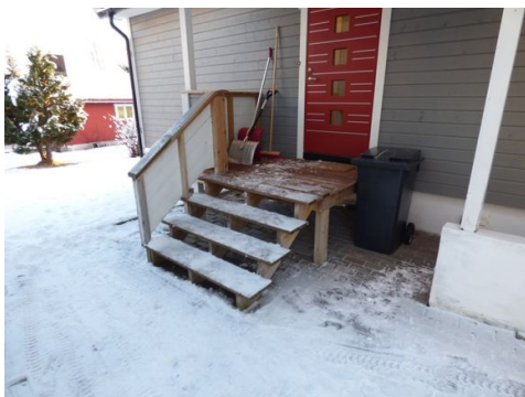
Trapp ved inngang
