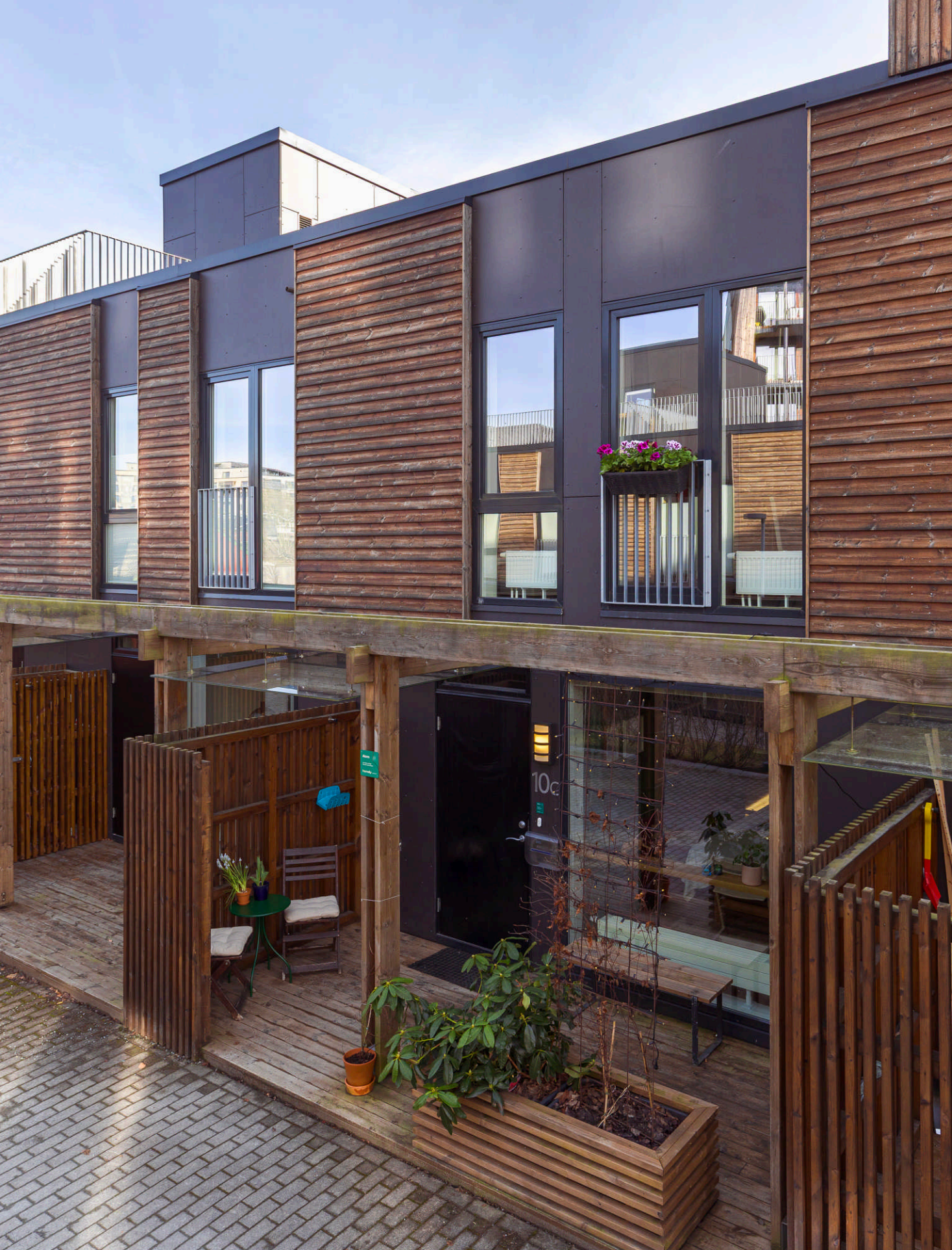
Rekkehusene i Dakota er tegnet av det anerkjente Oslo-kontoret Lund Hagem arkitekter. Fasadene har en stram og moderne utforming, med gode bygningstekniske løsninger som krever lite vedlikehold: Fasadeplater og vinduer er vedlikeholdsfrie.
