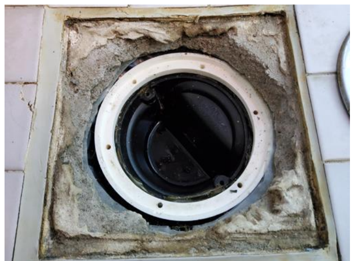
Membran, tettesjikt og overgang til sluk. - [Sluk i bad 1. etg.]
