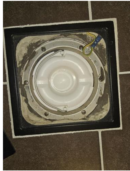
Våtrom - [Sluk bad]
