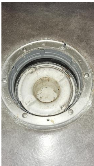
Overflater gulv - [Sluk bod]
