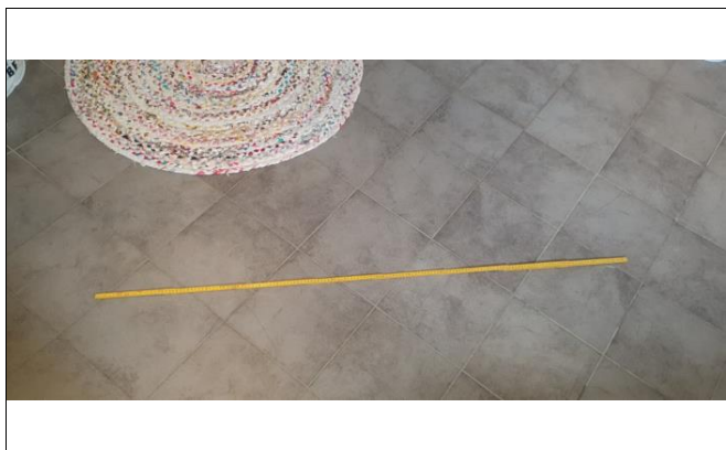
Bildet viser lengde på synlig sprekk i fliser.
