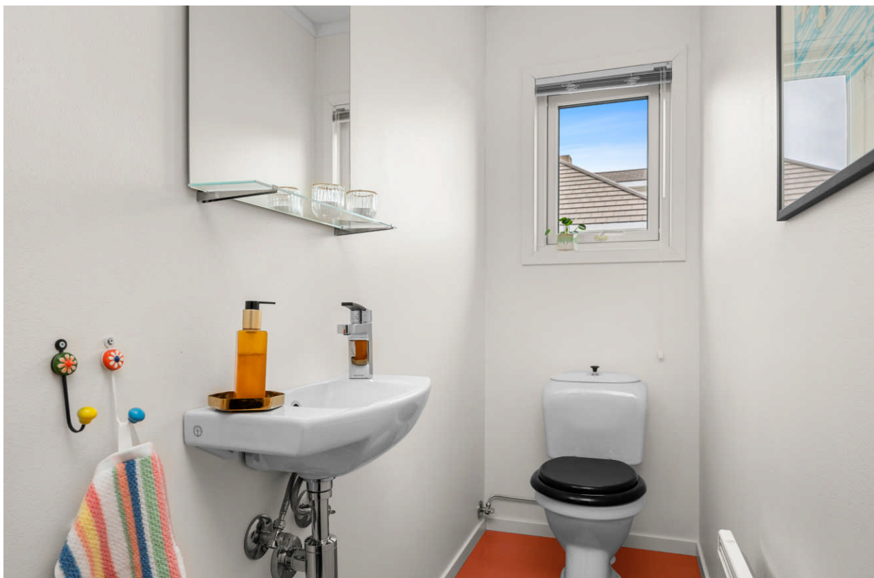
Separat toalettrom oppgradert i 2011 med nye rør, vask og vindu
