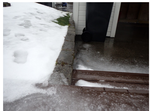
Bue på forstøtningsmur
