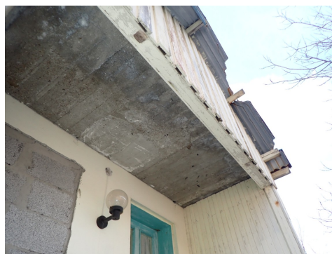
"Utkraget" betongdekke
