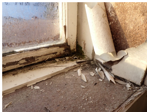
Fuktskade kjøkken
