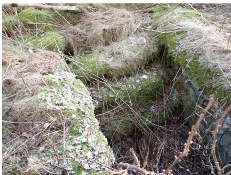
Trapp til kjellerinngang
