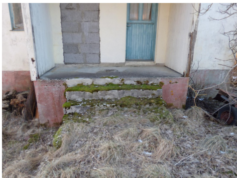
Trapp ved inngang
