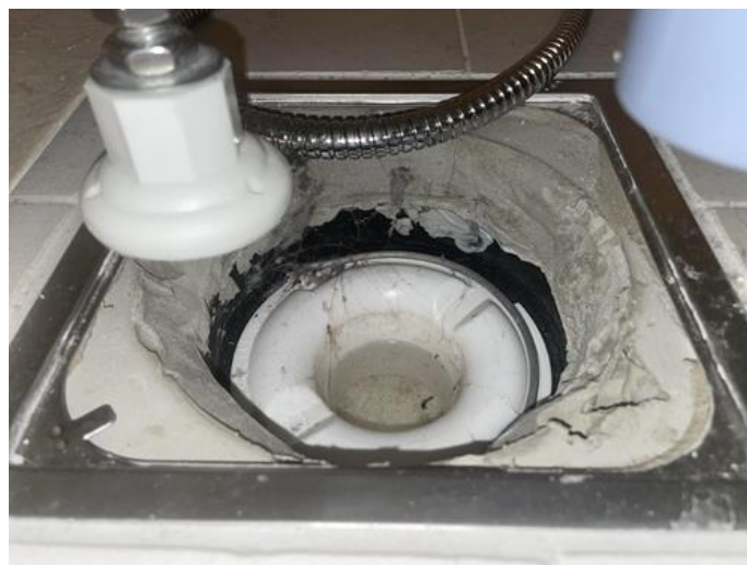
Membran, tettesjikt og overgang til sluk. - [Bad 2.etasje. Sluk under badekar.]
