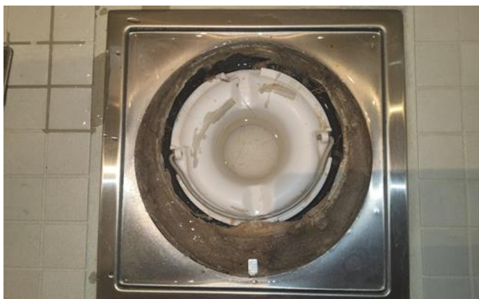
Membran, tettesjikt og overgang til sluk. - [Bad 2.etasje. Sluk i dusjsone.]
