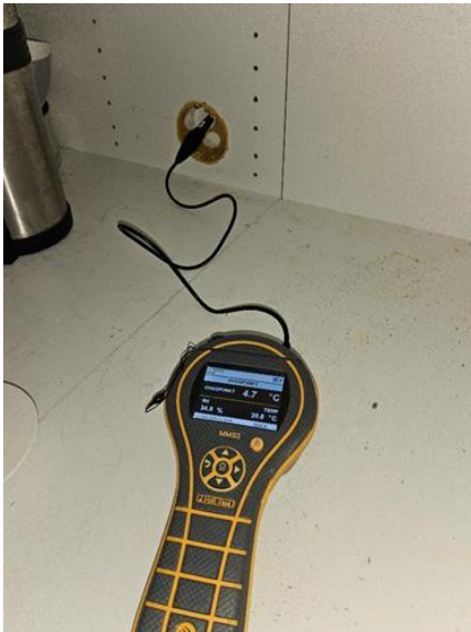
Våtrom - [Fuktmåling fra kjøkken mot dusjsone bad]
