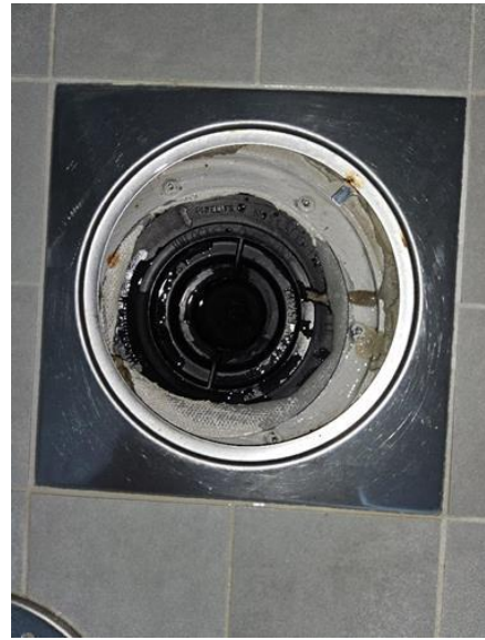
Våtrom - [Sluk bad]
