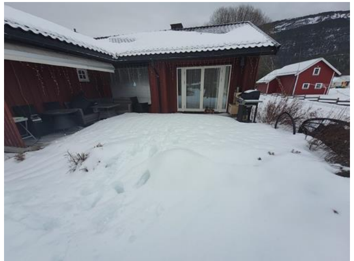
Terrasser / platting på terreng - [Snødekket terrasse ved stue. ]
