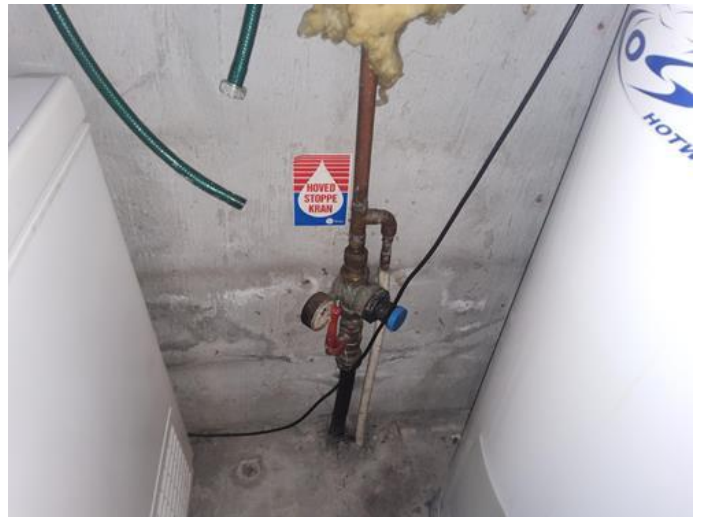
Hovedstoppekran - [Innvendig stoppekran.]
