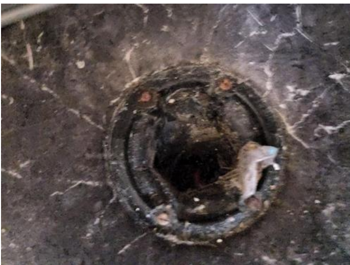
Avløpsrør (ink. sluk) - [Sluk på vaskerom.]
