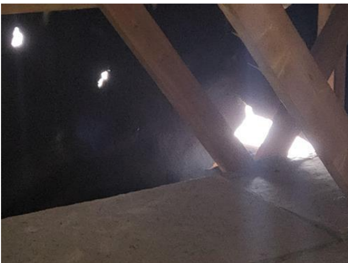
Detaljer inn mot tilstøtende konstruksjoner - [Overgang mellom garasjetak og tilstøtende yttervegg. Bildet er tatt fra innside kaldloft på boligen.]
