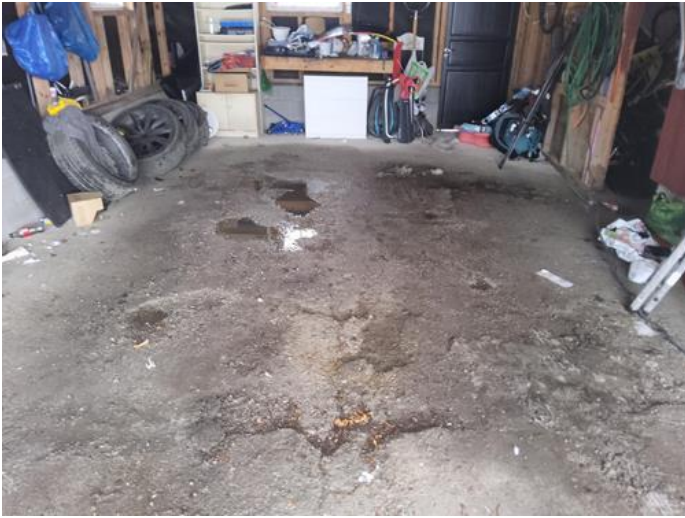
Øvrige rom [eksklusive spesialrom] - [Gulv i garasje.]
